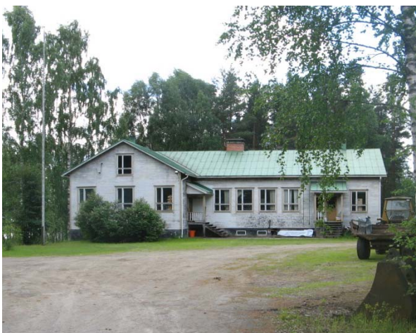
Kuva 24. Peltoniemen vanha koulurakennus.
