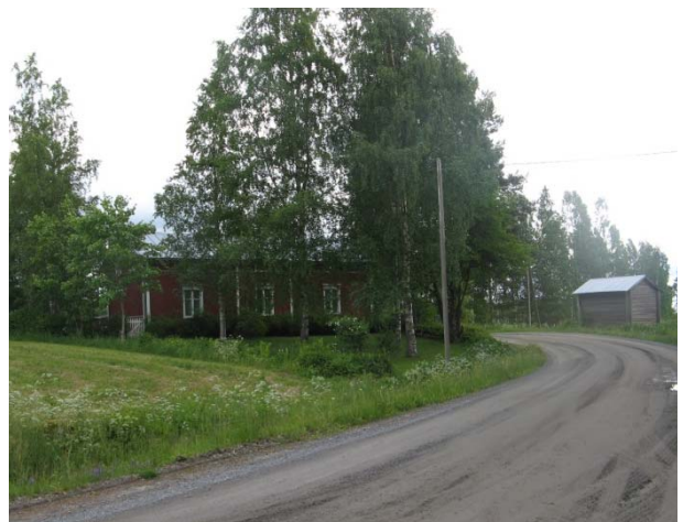
Kuva 25. Peltoniemen tilan päärakennus ja riihi.
